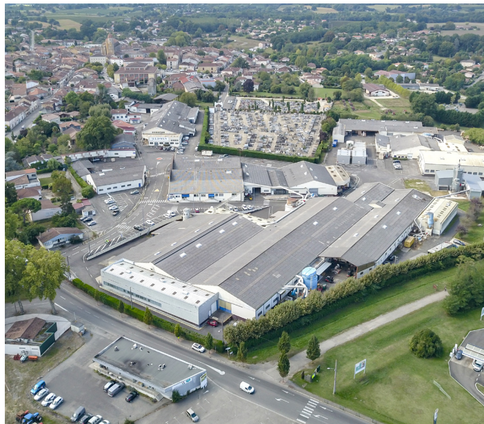
Usine d'Eauze dans le Gers
